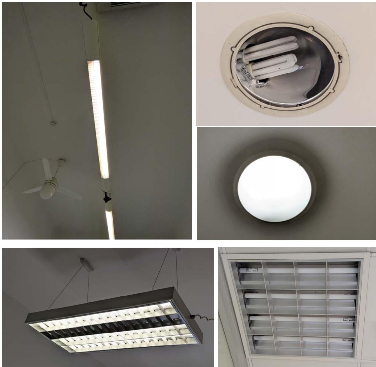
Figura 2 – esempi di corpi illuminanti fluorescenti attualmente installati
